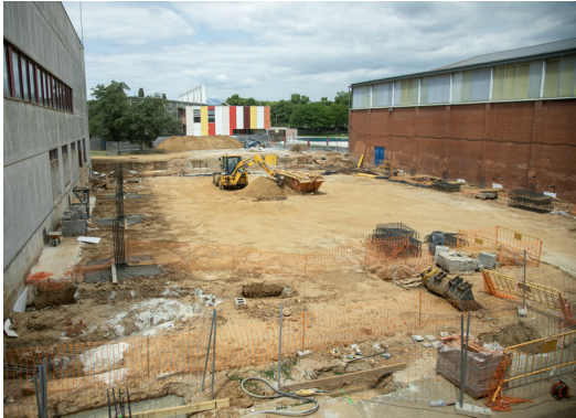
Detall de les obres del pavelló (al centre), a la zona esportiva del Pla, el dia 1, vistes des del camp de futbol. A l'esquerra, el pavelló de gimnàstica, i a la dreta, el pavelló municipal. QUIM PUIG.
