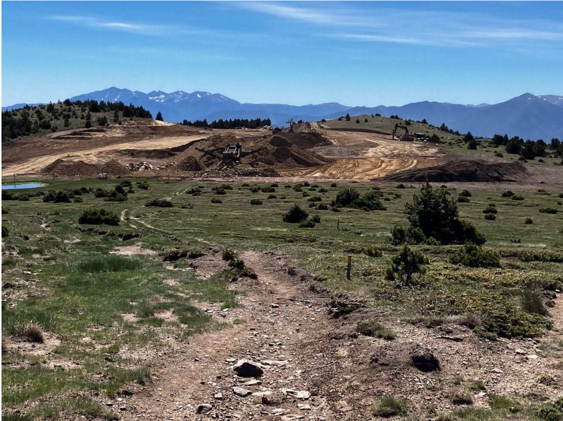
Movimiento de tierras en la zona del Roc d'Aude para la construcción del nuevo embalse.
