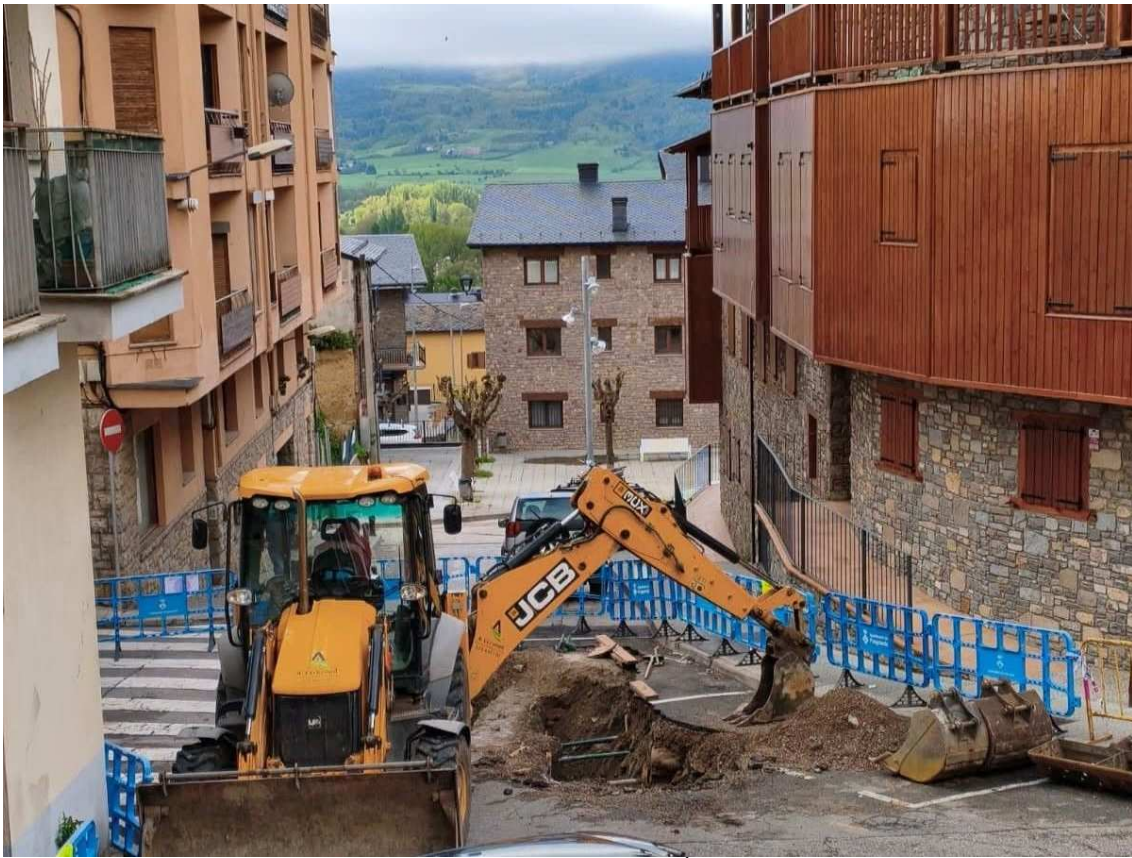
Unes obres de reparació de la via pública a Puigcerdà / AJ PUIGCERDÀ
