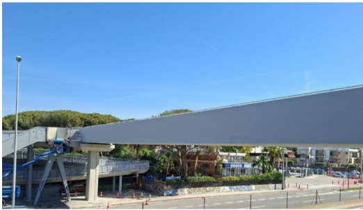
Resultat final de la nova passarel·la de la Pava, entre Castelldefels i Gavà GENERALITAT DE CATALUNYA / ACN.
