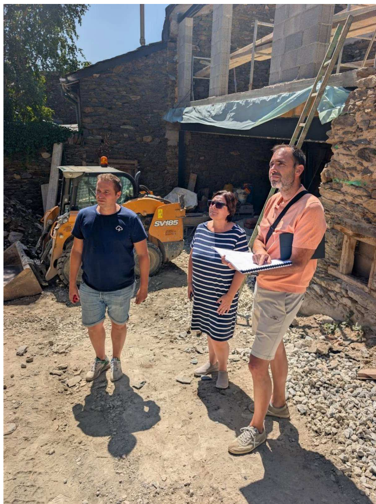
Una visita d'obres a cal Forner / AJ GUILS
