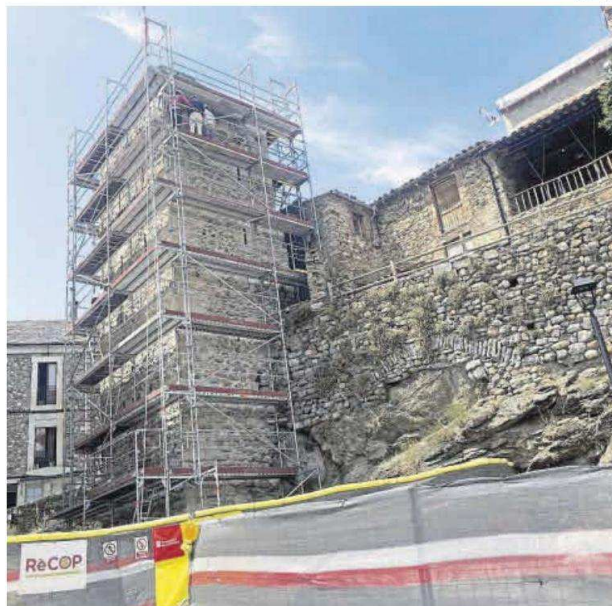
Les obres de restauració de la Torre de la Presó de Bellver
