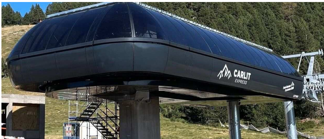
Estación de salida del nuevo telesilla Carlit Express de Font-Romeu Pyrénées 2000
