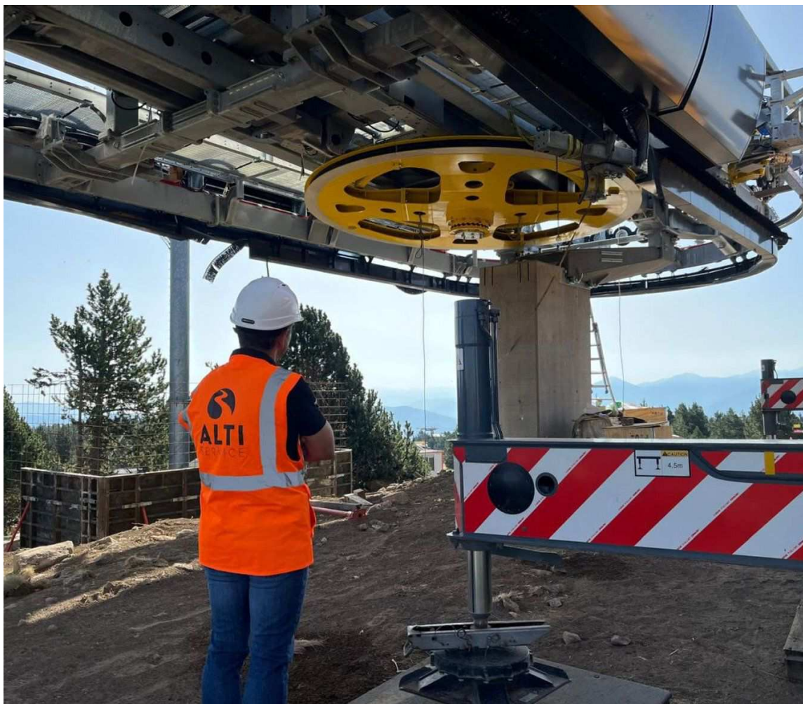
Un operario observa el montaje del volante de retorno del nuevo TSD6 Carlit Express de Font-Romeu Pyrénées 2000
