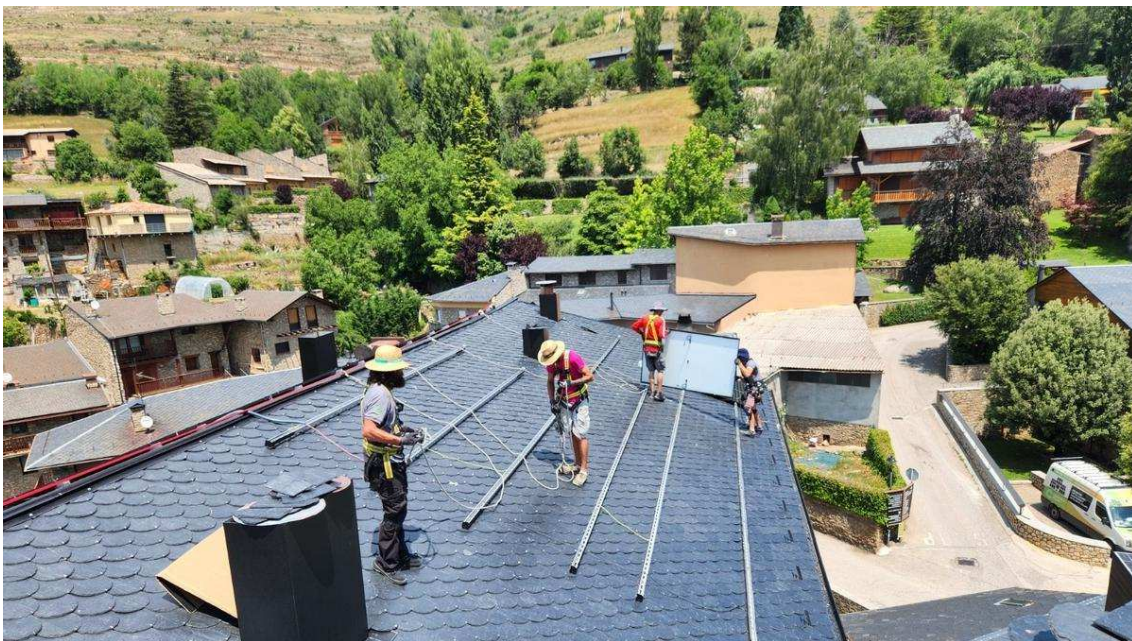
La instal·lació de plaques solars en un edifici de Prullans / Cerdanya Solar
