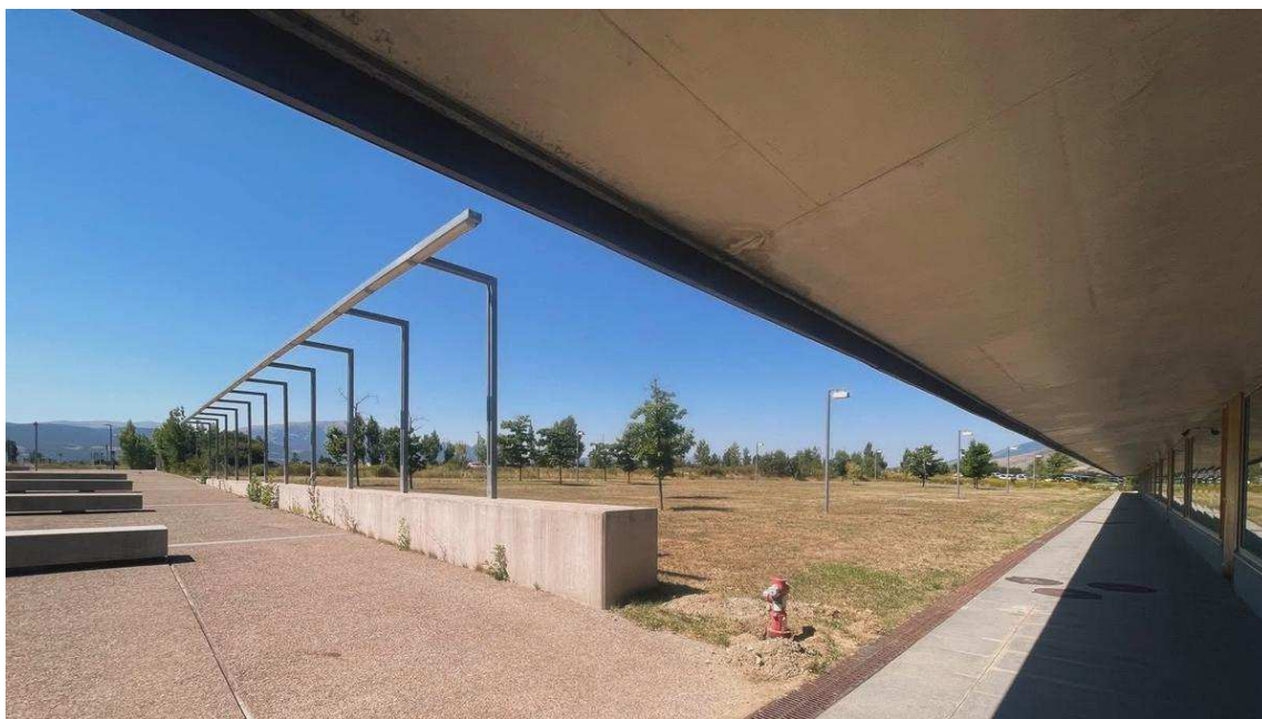
La zona on es farà el nou edifici de l'Hospital de Cerdanya / HC
