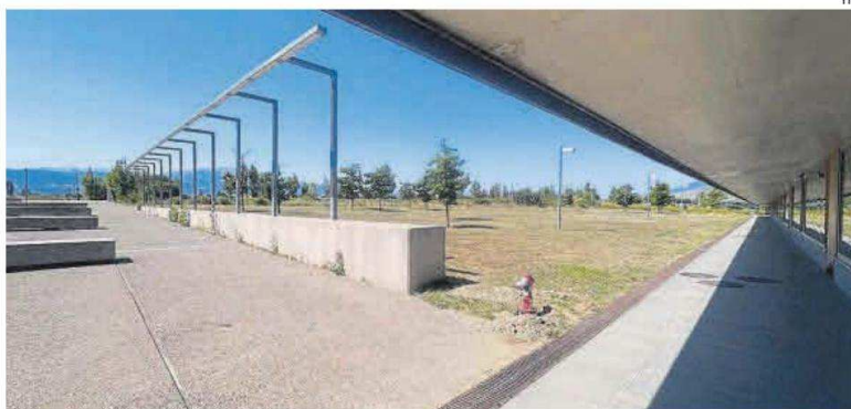
La zona on es farà el nou edifici de l'Hospital de Cerdanya
