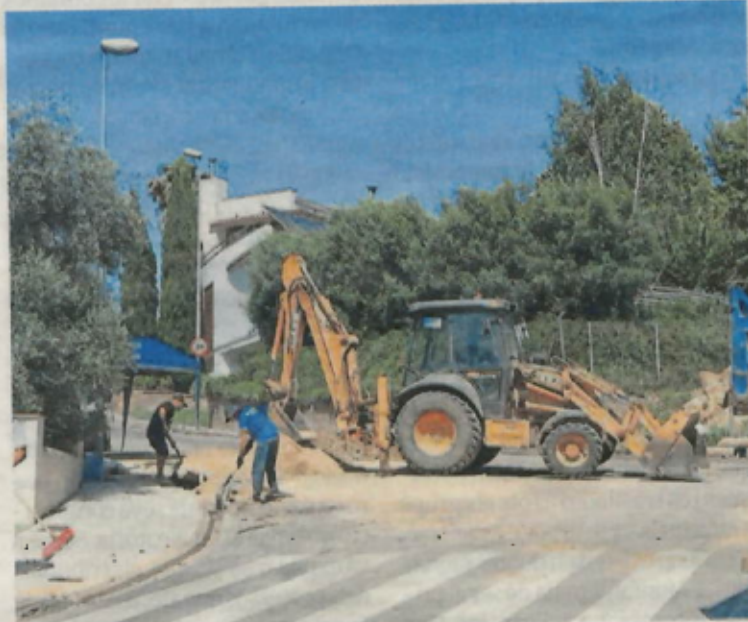
Treballs de reparació de les avaries a la Bisbal.
