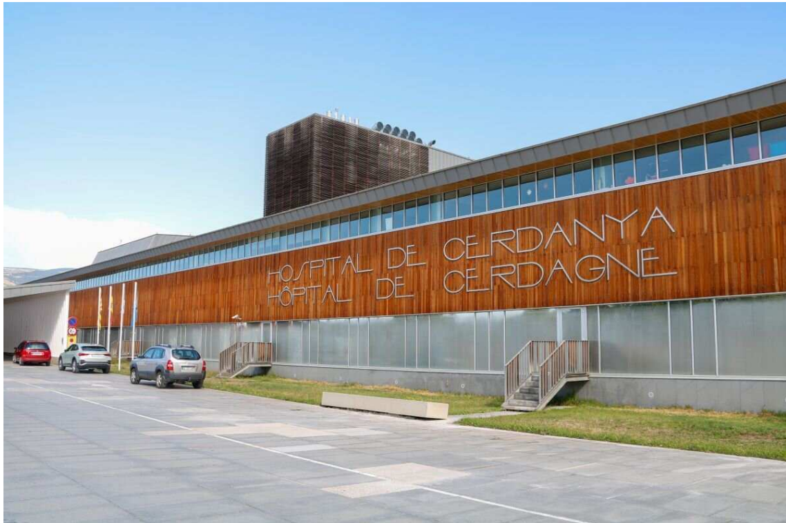
La façana de l'Hospital de Cerdanya / Marc Codinas
