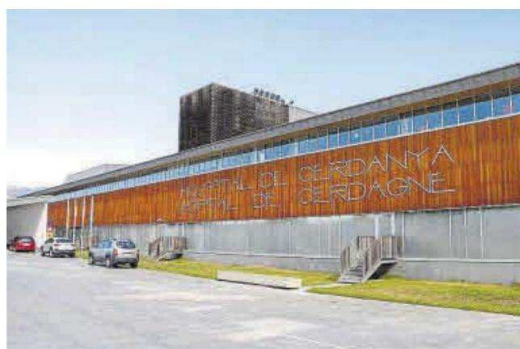
Façana de l'Hospital de Cerdanya
