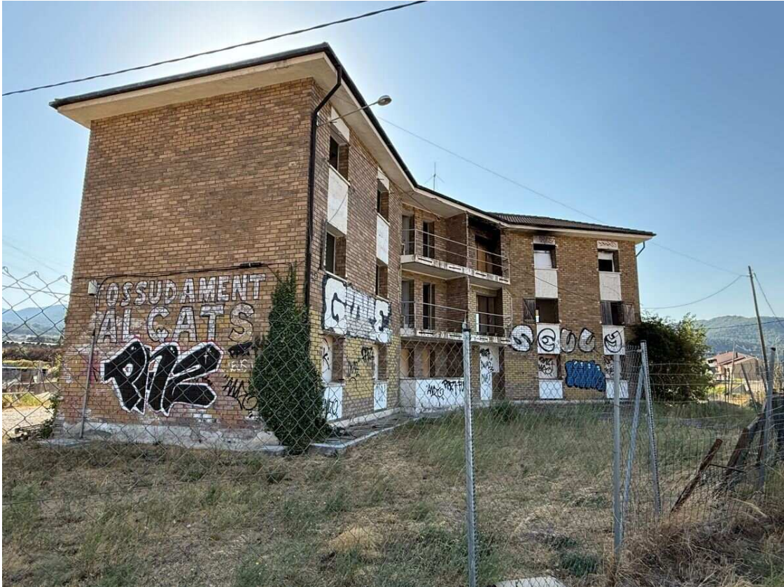
L'antiga caserna de la Guàrdia Civil d'Oliana acollirà 10 habitatges de lloguer assequible / Feliu Sirvent
