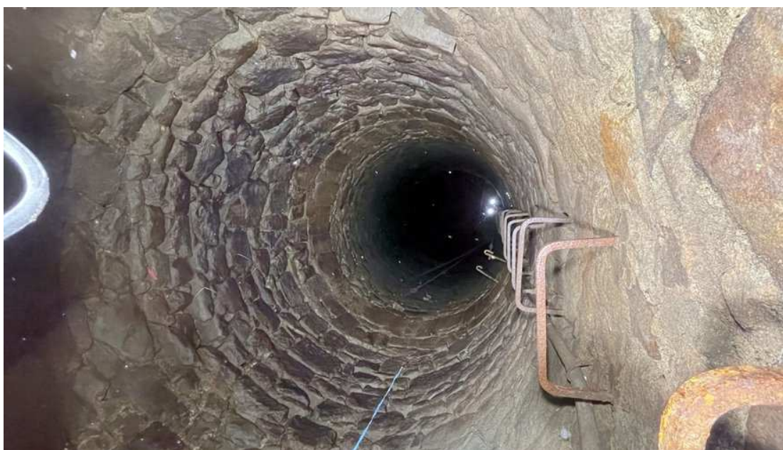
Le bâtiment du puits de la ville.
