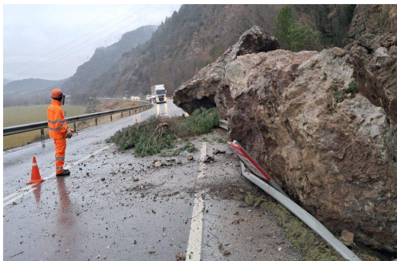
Operari treballant en la retirada de roques a l'esllavissada d'Hostalets de Tost / J.P.O. ARXIU
