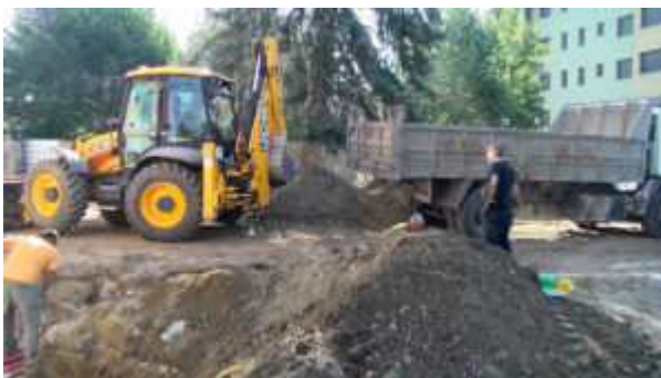
Maquinària treballant en l'ampliació de l'equipament / M.F.C.
