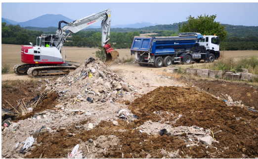
Una excavadora escampant la runa ACN.
