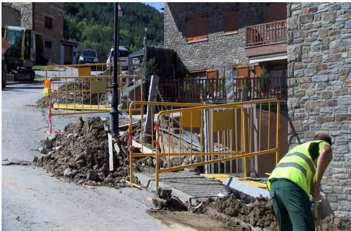
Obres de millora de la xarxa d'aigua potable d'Alp / M.F.C.
