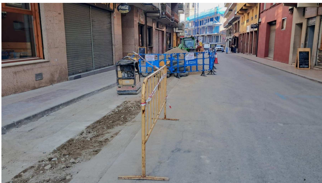
Endesa renova cablejat subterrani de Puigcerdà / @Endesa
