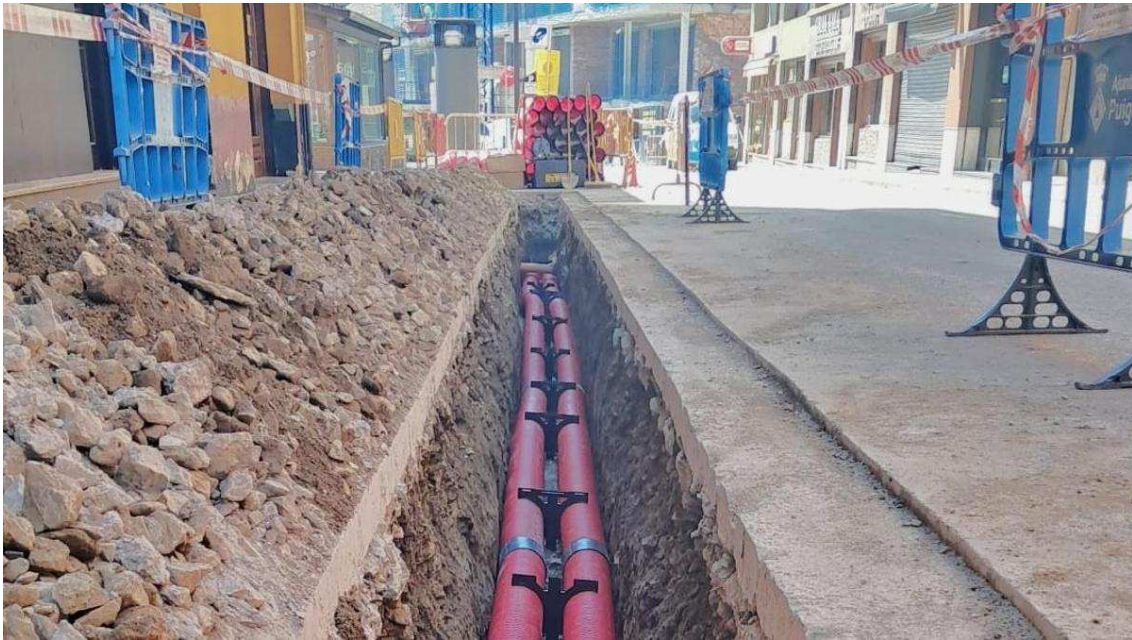
El tram que Endesa ha renovat del carrer Major de Puigcerdà. / ENDESA
