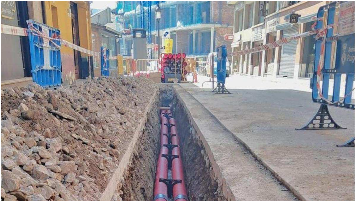
Les obres de renovació de la línia elèctrica / ENDESA
